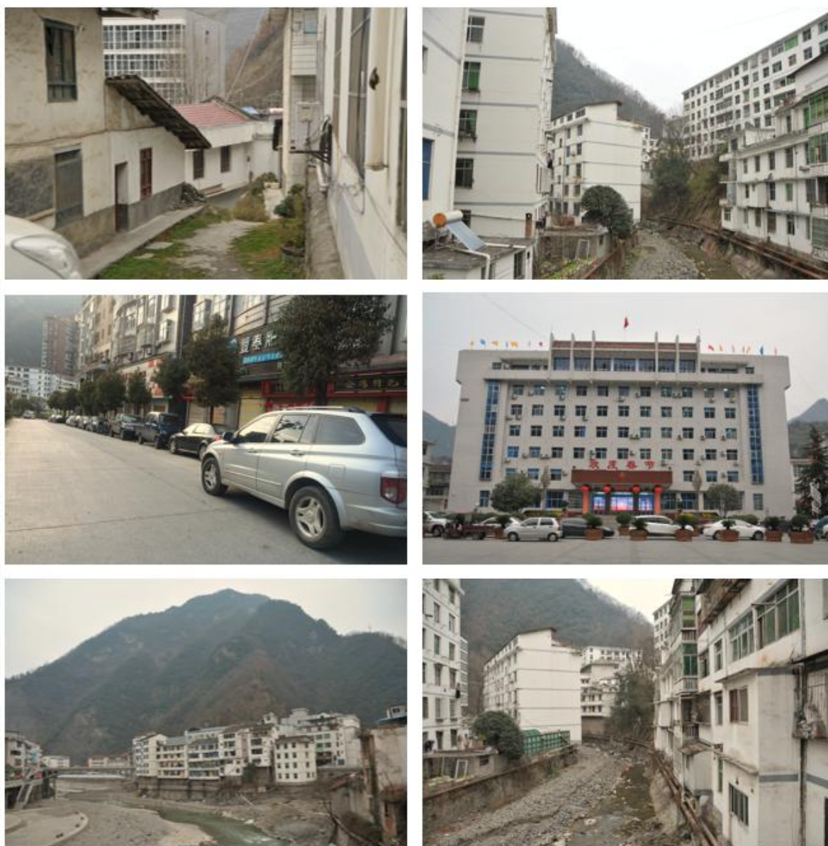
项目区现状照片
