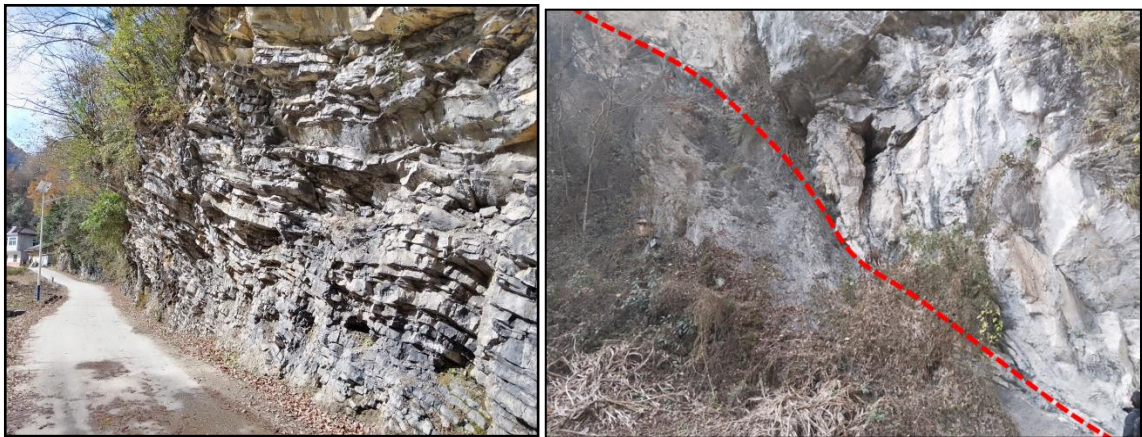
图2-6 裂隙发育的灰岩及断裂地表露头点
